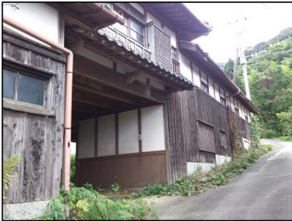
▲立花口の空き家
